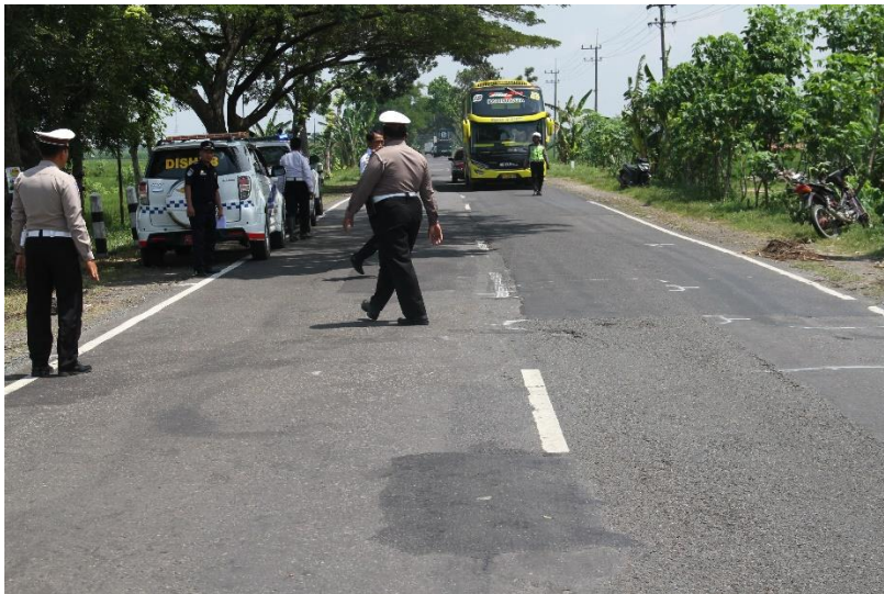
Gambar 3. Kondisi marka tepi dan marka tengah di lokasi kejadian
