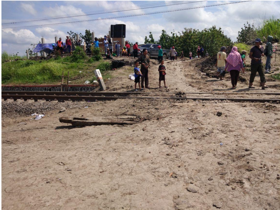
Gambar 5. Pintu Perlintasan Tidak Dilengkapi dengan Pintu
