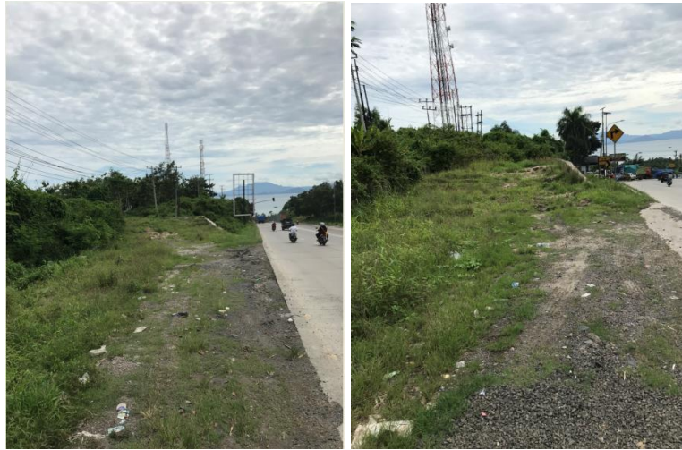
Gambar 19. Kondisi Jalur Penyelamat
