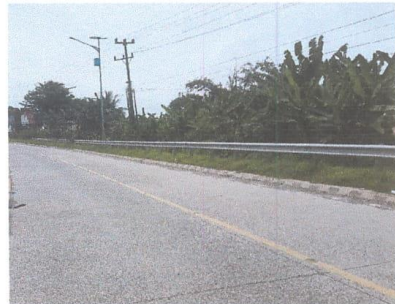
Guardrail yang telah diperbaiki (foto atas diambil dari arah Bandar Lampung, foto bawah diambil dari arah Bakauheni)
