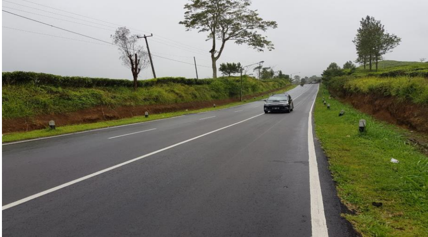
Gambar 21. Lingkungan Sepanjang Jalan Raya Subang Ciater Kabupaten Subang
