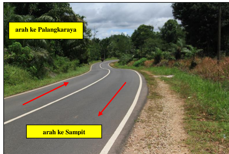
Gambar 13. Kondisi ruas jalan Tjilik Riwut yang menikung sekitar 200 meter dari lokasi kecelakaan
