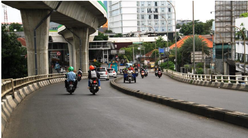
Gambar 6. Kondisi jalan pada lokasi terjadinya kecelakaan.
