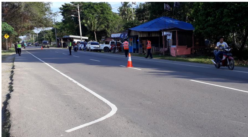
Gambar 7. Marka Jalan terlihat jelas
