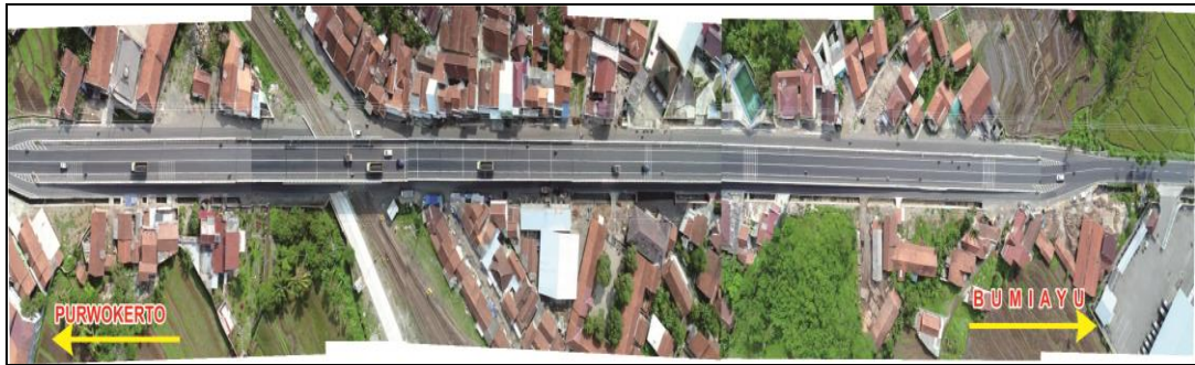
Gambar 14. Foto Flyover Kretek dari Udara
