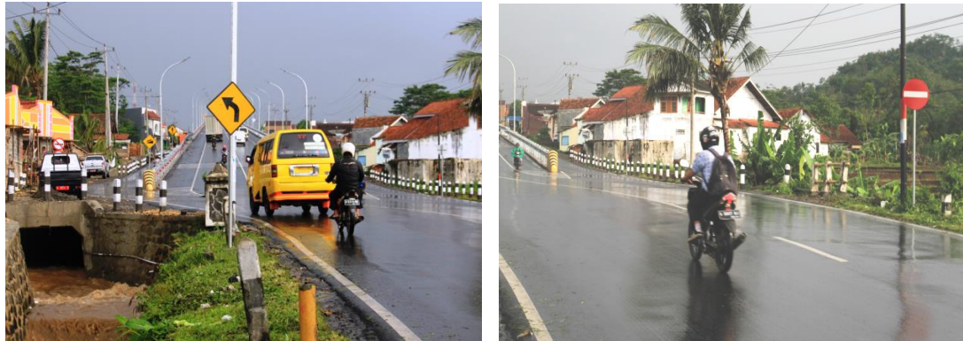
Gambar 20. Penempatan Rambu Yang Tidak Sesuai
