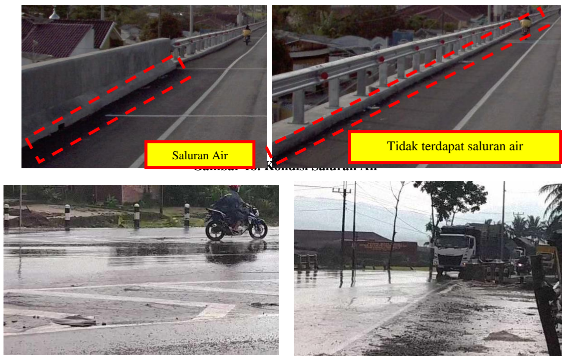
Gambar 19. Genangan di Ujung Turunan Flyover
