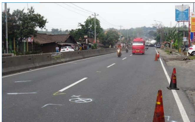
Gambar 44. Tidak terdapat rambu-rambu.
