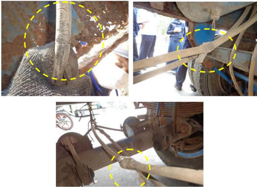
Gambar 32. Kondisi selang fleksibel rem kereta tempelan.
