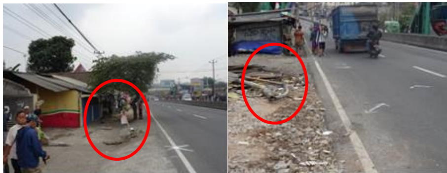
Gambar 47. Warning Light Patah tertabrak truk kayu.
