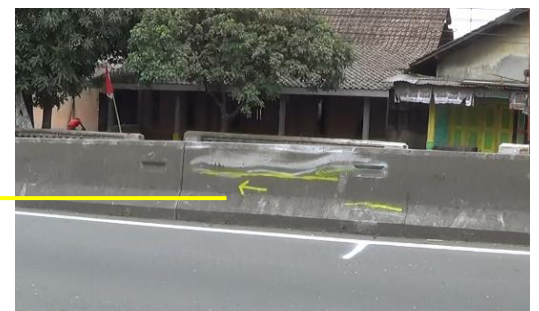
Gambar 54. Benturan, jejak ban, dan scratchmark pada kejadian kecelakaan.
