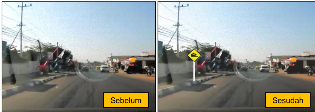
Gambar 27. Simulasi Pemasangan Rambu Peringatan Turunan Landai
