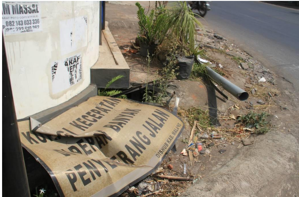
Gambar 6. Kerusakan Tiang dan Papan Rambu Peringatan
