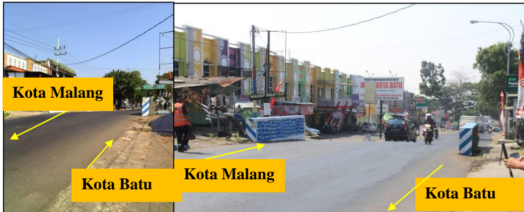
Gambar 25. Kemiringan jalan 75 meter sebelum tempat kejadian kecelakaan 9.9 %
