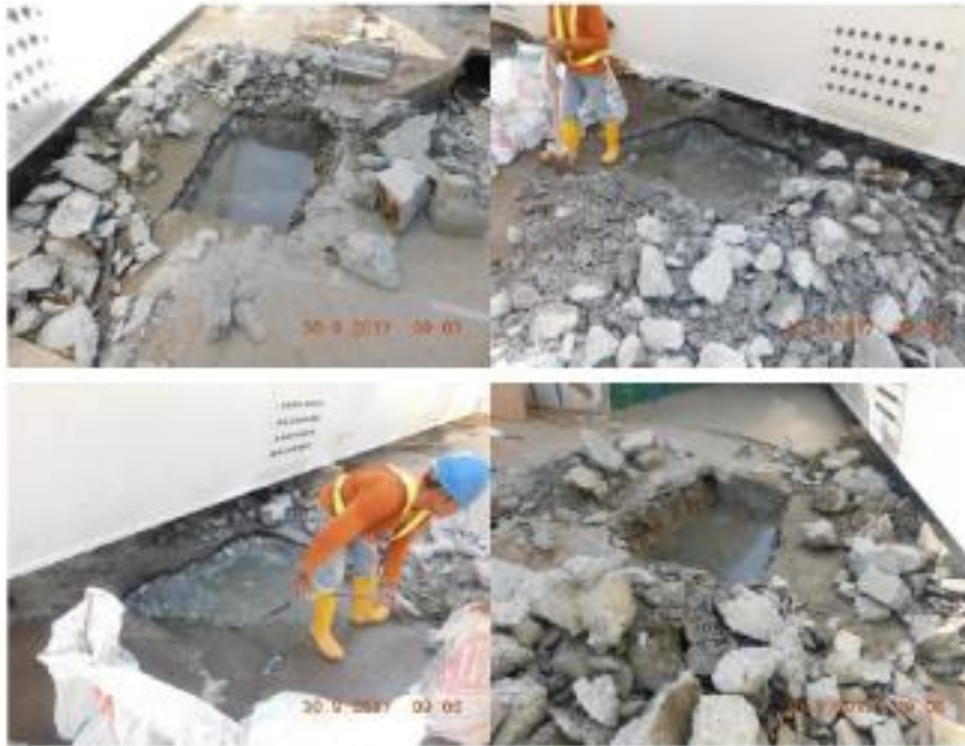
Gambar 2. Tes Pit untuk Pijakan TS.
