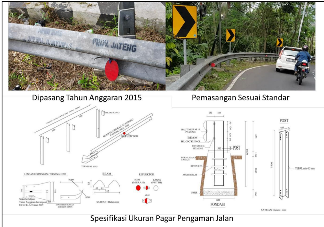
Gambar 16. Pagar Pengaman Jalan Dipasang Tahun 2015 Sesuai Standar
