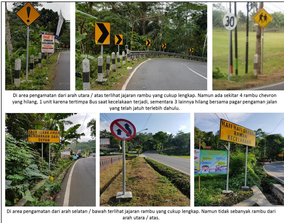
Gambar 12. Kondisi Rambu di Area Pengamatan Lokasi Kejadian Kecelakaan
