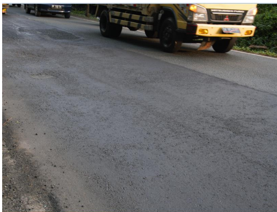
Gambar 19. Kondisi marka yang tertutup overlay
