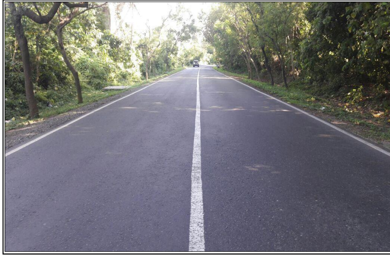
Gambar 21. Perbaikan Marka Jalan Cekik-Batas kota Negara (Km.121-122)
