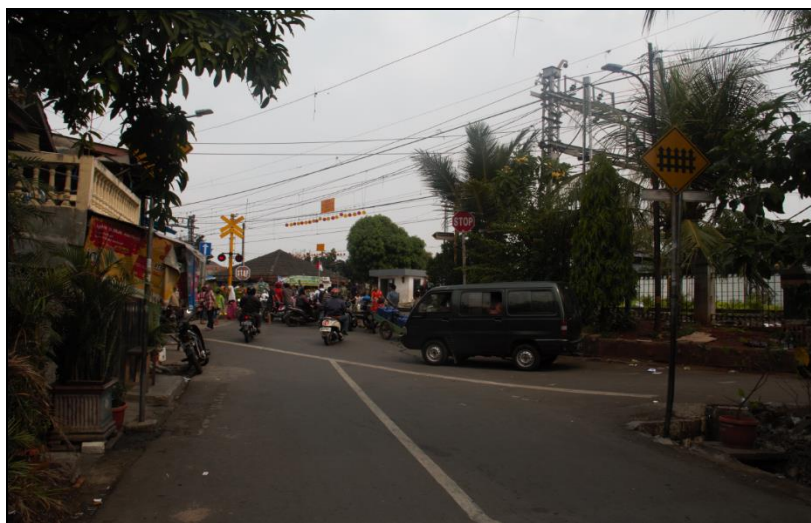
Gambar 13. Ruas jalan Tanah Tinggi I terdapat marka tengah utuh
