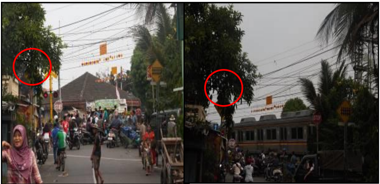
Gambar 9. Rambu peringatan tertutup rimbunan pohon
