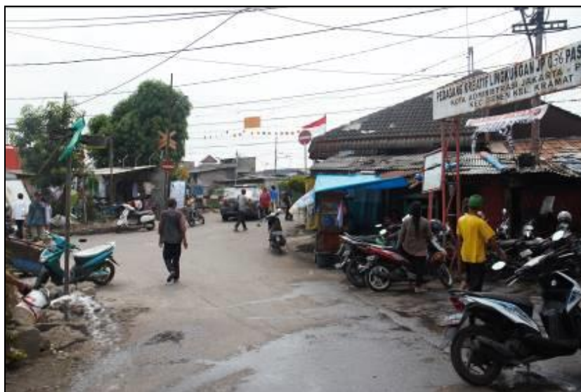
Gambar 17. Kondisi ruas jalan Kembang Pacar
