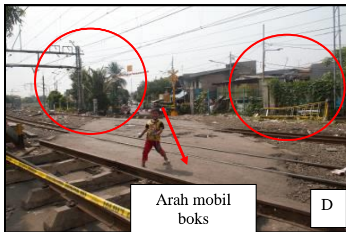
Gambar 18. Kondisi lingkungan di ruas jalan Tanah Tinggi (arah datangnya mobil boks)
