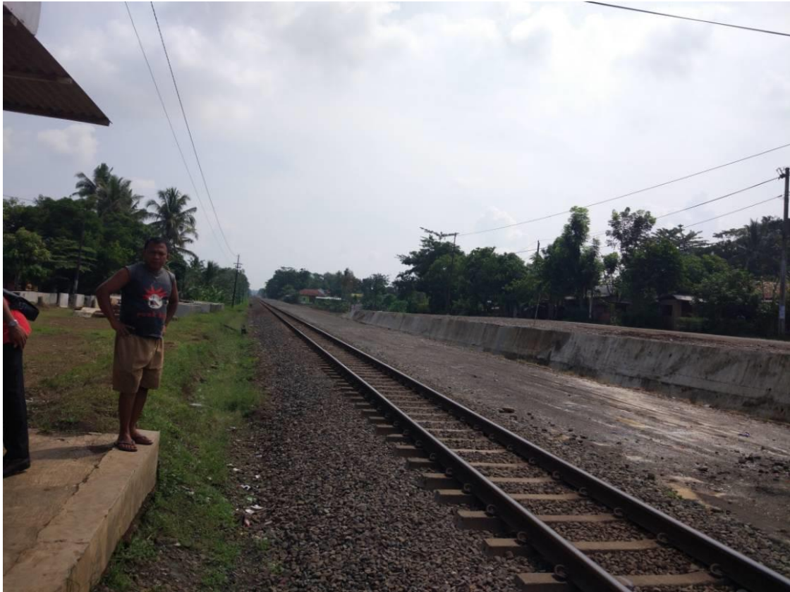
Gambar 9. Track perlintasan yang sedang dibangun jalur ganda
