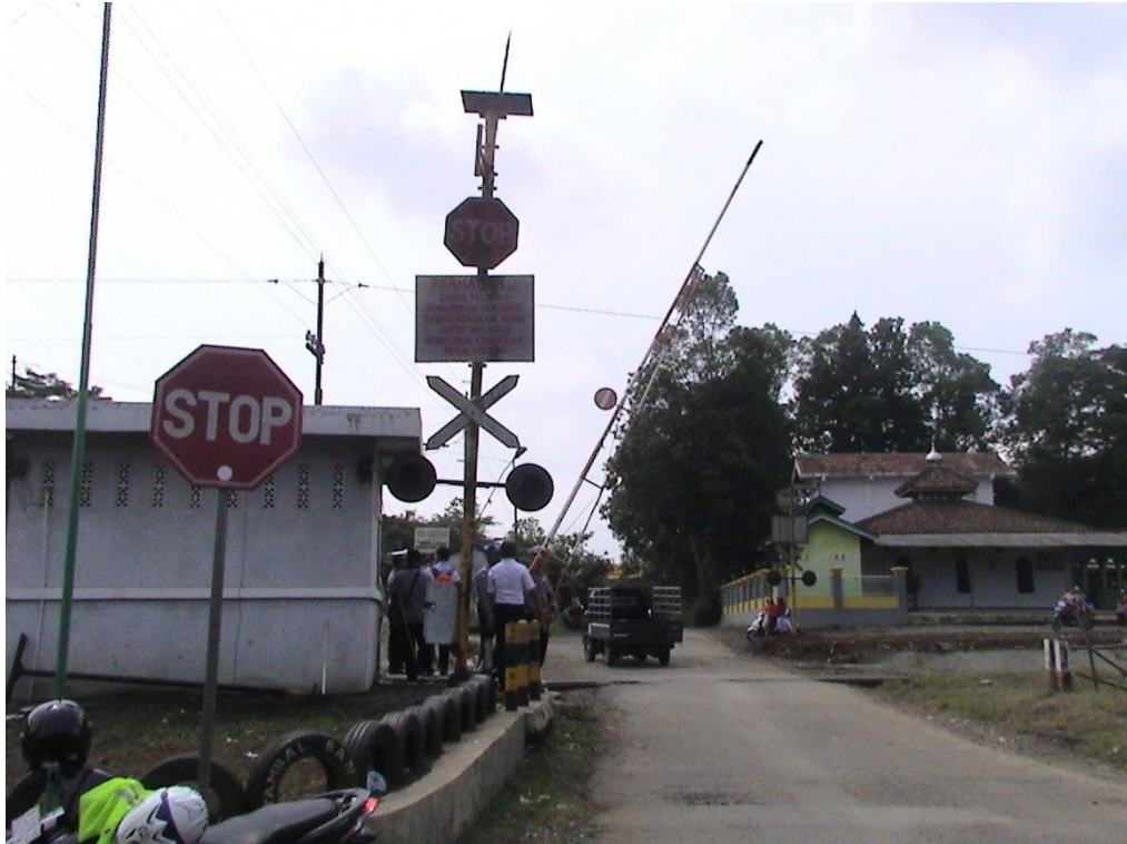
Gambar 4. Pintu Perlintasan dengan pintu penutupan hanya pada satu arah, sedangkan arah dari Cilacap – Buntu tidak dilengkapi pintu
