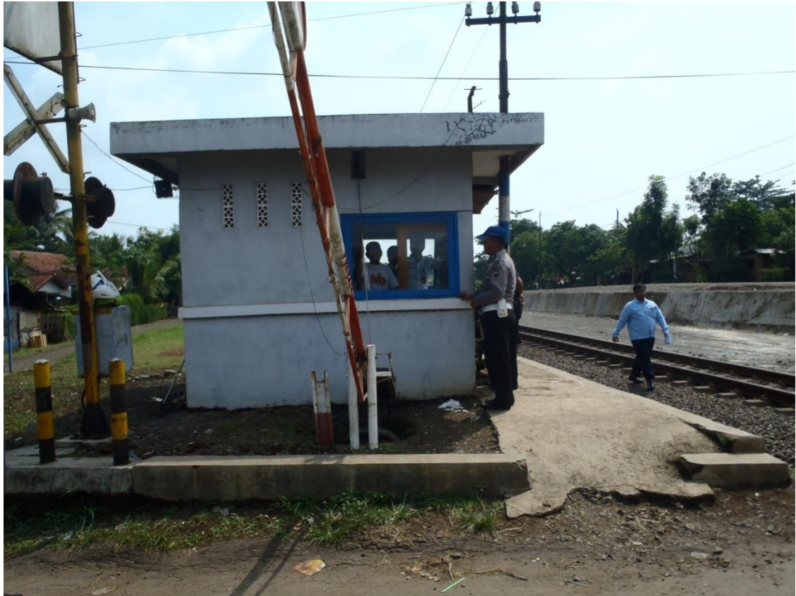
Gambar 6. Pos Penjagaan Pintu Perlintasan yang masih manual penutupan pintunya
