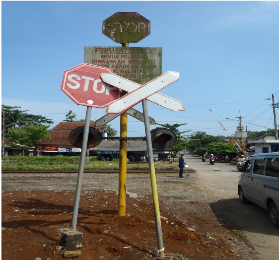
Gambar 10. Pemasangan rambu yang tidak standar dan tidak beraturan
