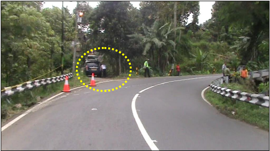
Gambar 13. Akses jalan pada tikungan lokasi terjadinya kecelakaan.
