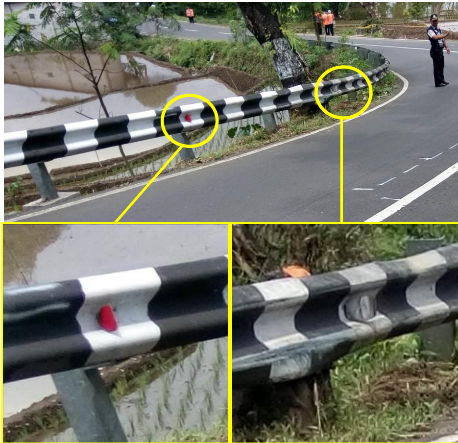
Gambar 18. Kondisi reflektor yang terpasang pada pagar pengaman jalan 20 meter menjelang lokasi terjadinya kecelakaan (dari arah Purbalingga menuju Pemalang).
