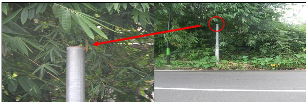
Gambar 17. Lampu Penerangan Jalan Umum yang rusak.
