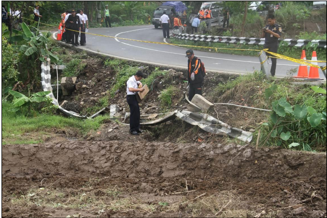
Gambar 12. Pagar pengaman jalan yang rusak akibat tertabrak mobil bus.
