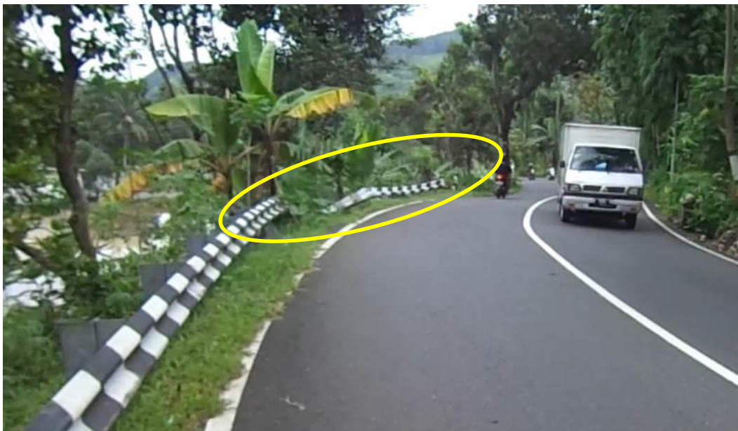
Gambar 15. Kondisi jalan 100 meter menjelang lokasi terjadinya kecelakaan.
