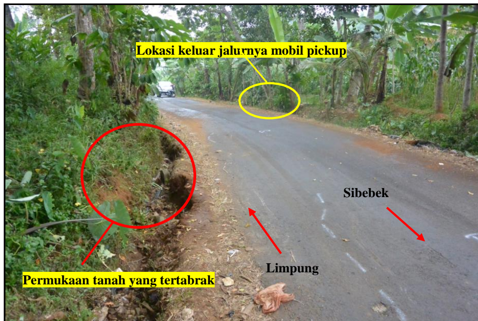
Gambar 15. Kondisi jalan 20 meter sebelum lokasi terhentinya mobil pickup .
