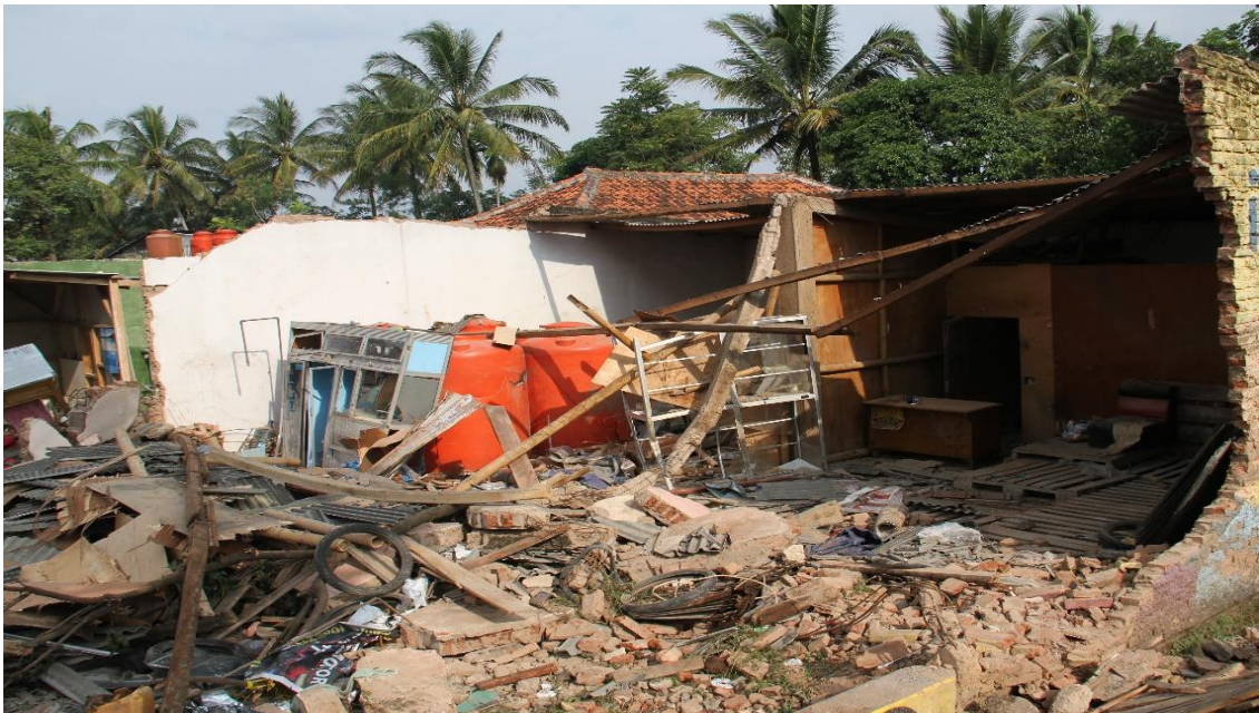
Gambar 31. Kondisi toko/depo isi ulang air minum depo setelah kecelakaan.
