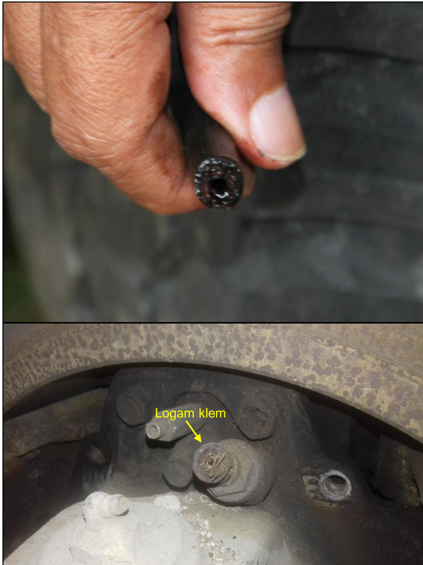
Gambar 2. Selang fleksibel rem roda kiri – depan terputus dari ujung logam klemnya yang dalam kondisi kering.
