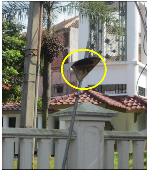
Gambar 17. Kondisi rambu peringatan tanjakan yang terlipat
