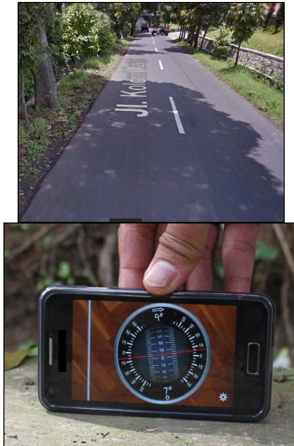
Gambar 15. Kondisi Jalan Turunan
