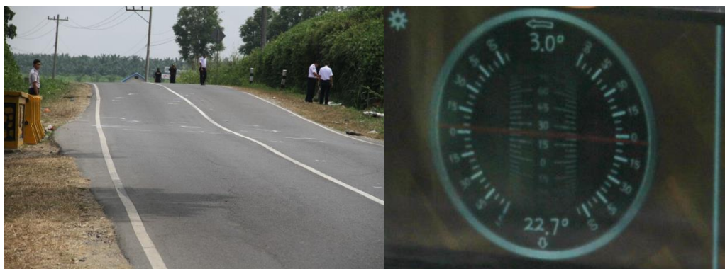
Gambar 5. Kondisi jalan dari arah Medan ke Pekanbaru setelah lokasi kecelakaan menurun 5,2%.
