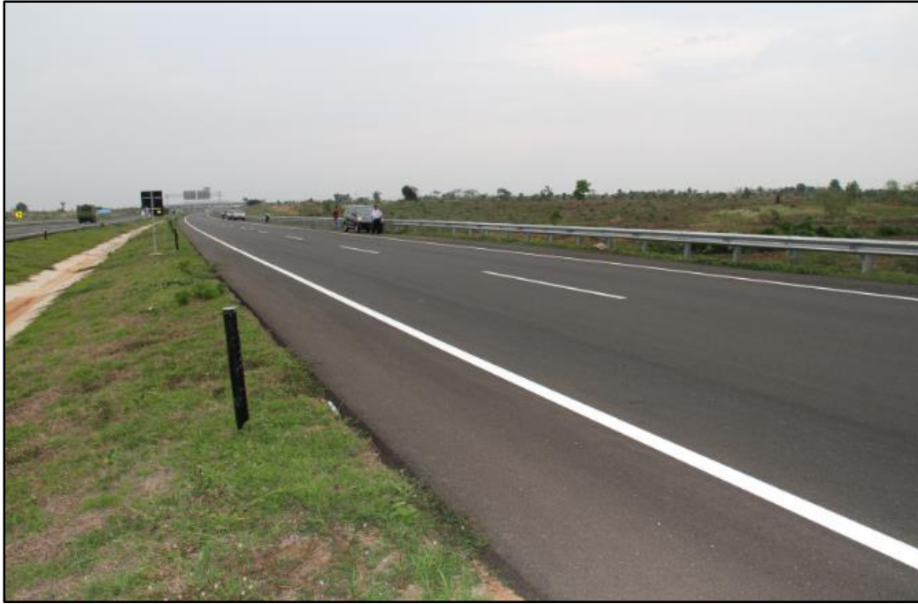
Gambar 8. Kondisi lingkungan kejadian kecelakaan
