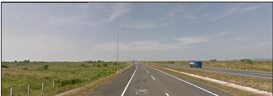
Gambar 10. Kondisi ruas jalan Tol Cikopo-Palimanan
