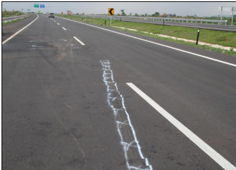
Gambar 7. Fasilitas pendukung jalan
