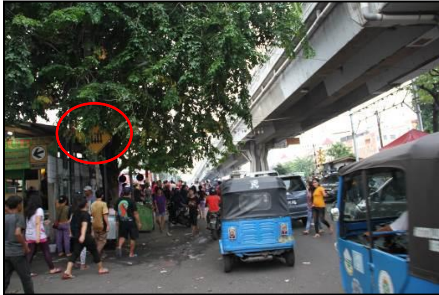
Gambar 21. Rambu peringatan adanya perlintasan kereta api yang dijaga dalam kondisi tertutup pohon yang rimbun sehingga tidak dapat terbaca oleh pengguna jalan.
