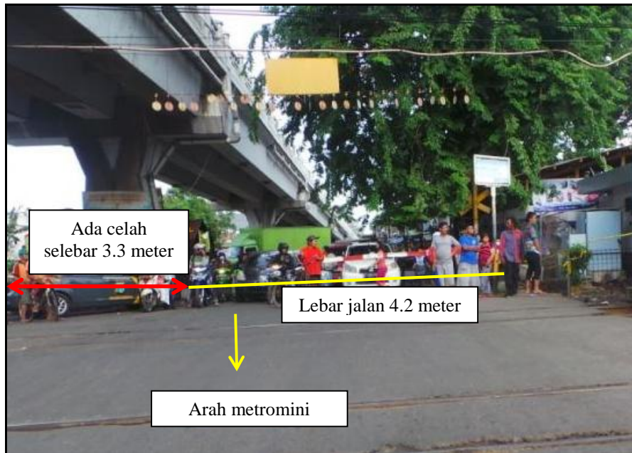
Gambar 22. Ruas jalan Tubagus Angke yang tidak ada marka tengah dan marka tepi serta terdapat celah selebar 3.3 meter
