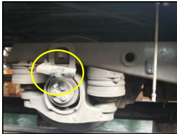
Gambar 15. Leveling valve patah 1 buah.
