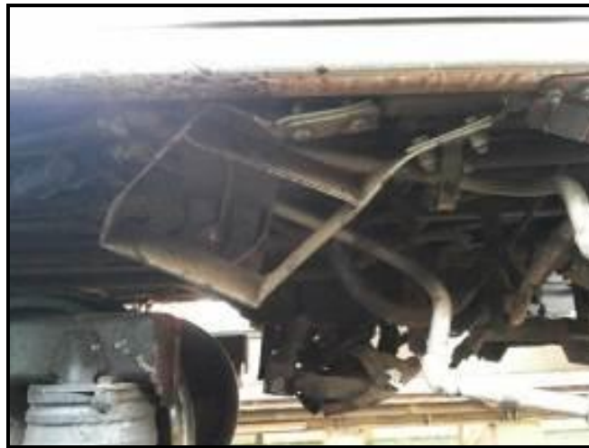
Gambar 8. Tangga masinis rusak kiri dan kanan
