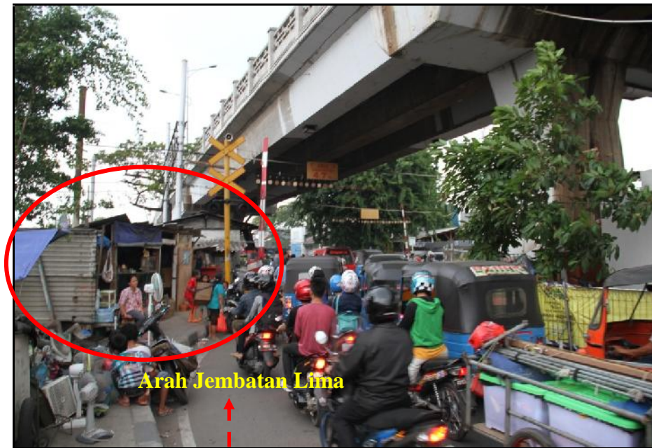
Gambar 28. Jarak pandang bebas pengemudi dari arah Kalideres menuju Jembatan Lima terhalang bangunan liar
