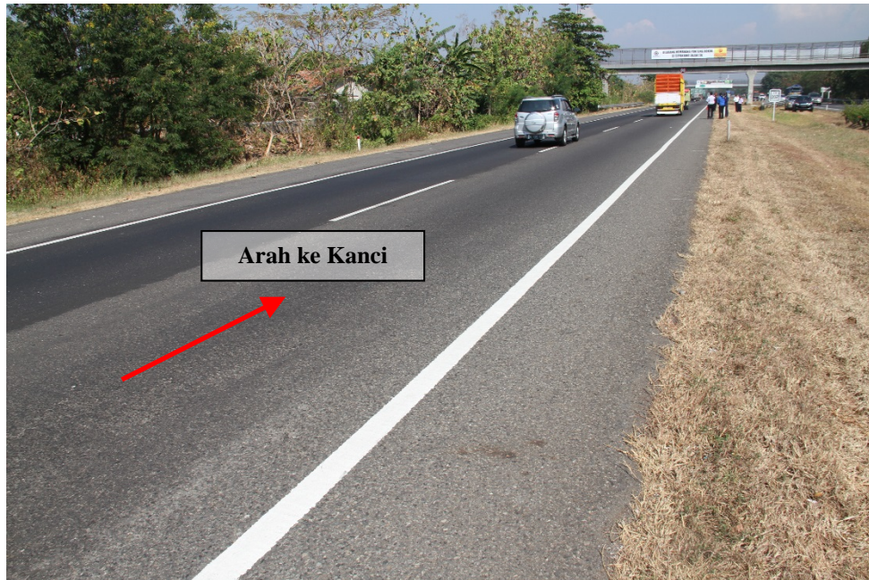
Gambar 19. Kondisi ruas jalan Tol Palikanci sekitar 200 meter sebelum lokasi kecelakaan.
