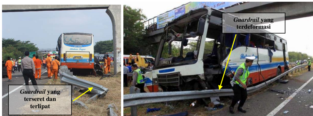
Gambar 17. Kondisi guardrail akibat tertabrak oleh mobil bus.
