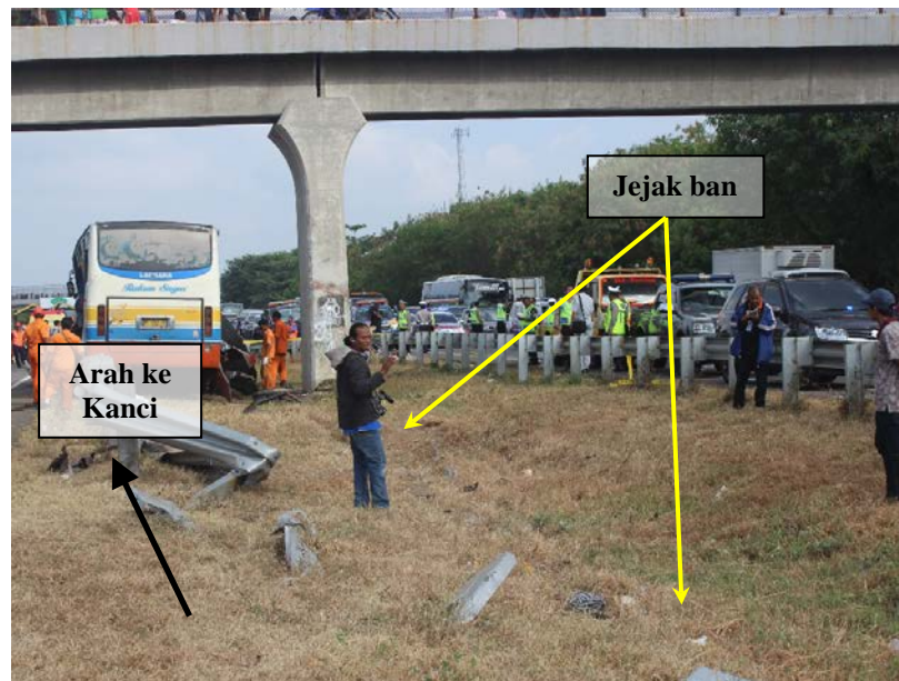
Gambar 14. Jejak ban yang terlihat mengarah ke lokasi tiang penyangga JPO yang tertabrak mobil bus
