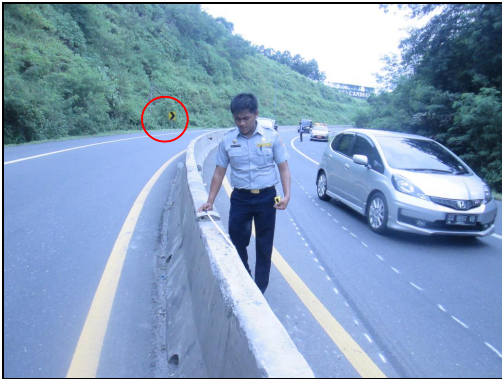
Gambar 17. Rambu peringatan jalan menikung (rambu chevron ).
