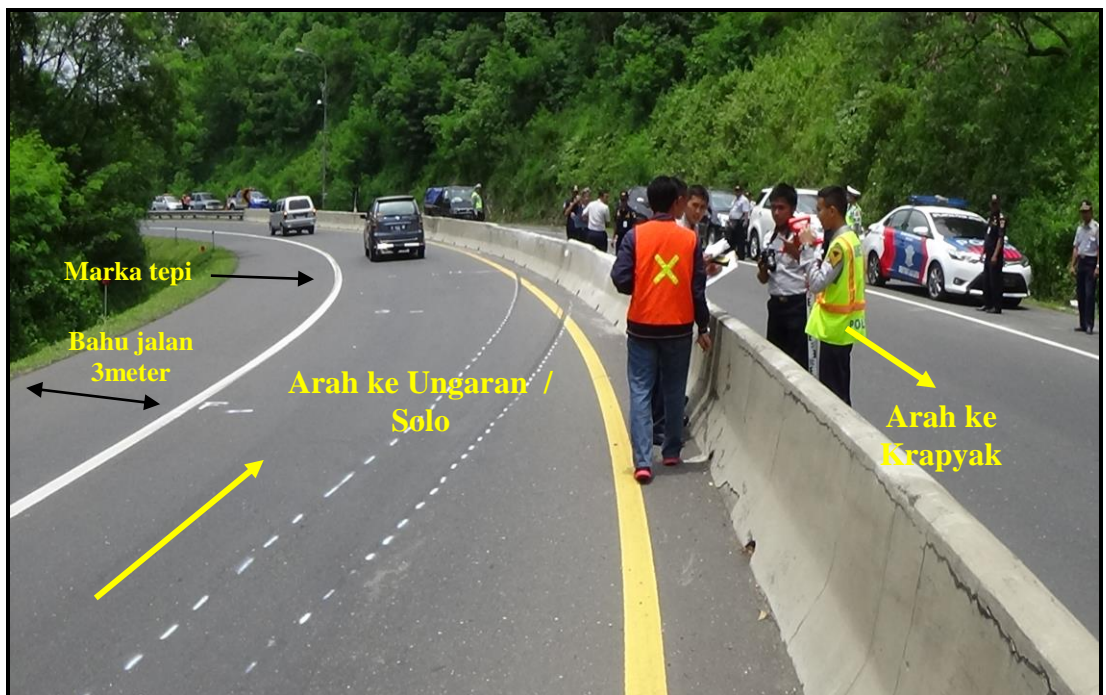
Gambar 19. Kondisi ruas jalan tol Jatingaleh arah menuju Ungaran/Solo.
