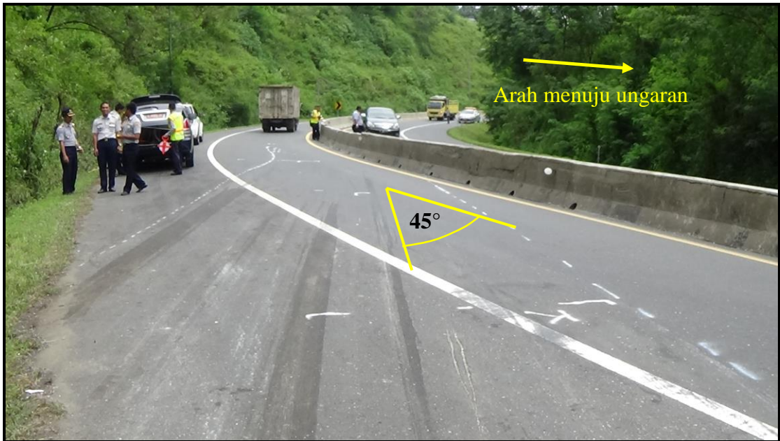
Gambar 14. Goresan pada permukaan dan marka tepi jalan.
