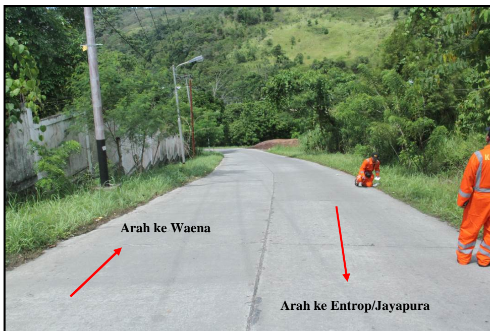
Gambar 12. Kondisi jalan alternatif Perumnas III Waena – Entrop 200 m menjelang pertigaan lokasi TKP.
