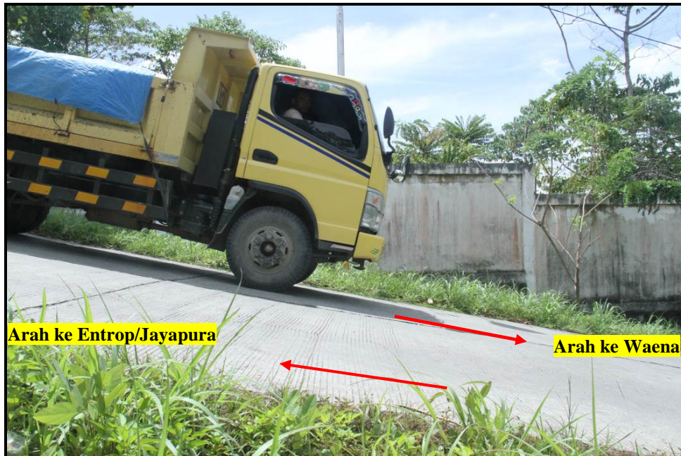
Gambar 13. Kondisi ruas jalan alternatif Perumnas III Waena – Entrop menurun dengan kemiringan vertikal \pm 10^{\circ} - 12^{\circ}
