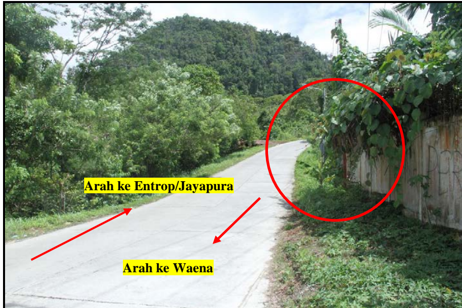
Gambar 27. Rerimbunan pohon yang berada tepat di tikungan sekitar 150 meter sebelum lokasi kejadian (Arah Waena menuju Entrop).
