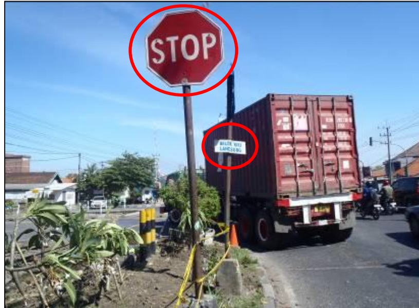
Gambar 27. Rambu dilarang berjalan terus (Tabel III no. 1a) dan rambu perintah Belok Kiri Langsung (Tabel IV no. 8) sebelum perlintasan sebidang (dari Jl. Buduran (Gedangan) menuju Jl. Lingkar Timur).
