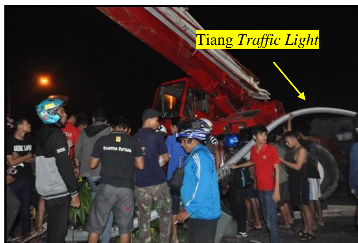
Gambar 16. Tiang traffic light yang bengkok akibat terbentur mobil crane.
