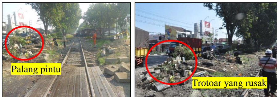
Gambar 15. Kondisi palang pintu perlintasan dan kelengkapannya setelah terjadinya kecelakaan.
