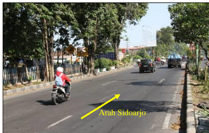
Gambar 28. Kondisi marka di ruas jalan Buduran 100 m sebelum JPL (arah dari Surabaya ke Sidoarjo)
