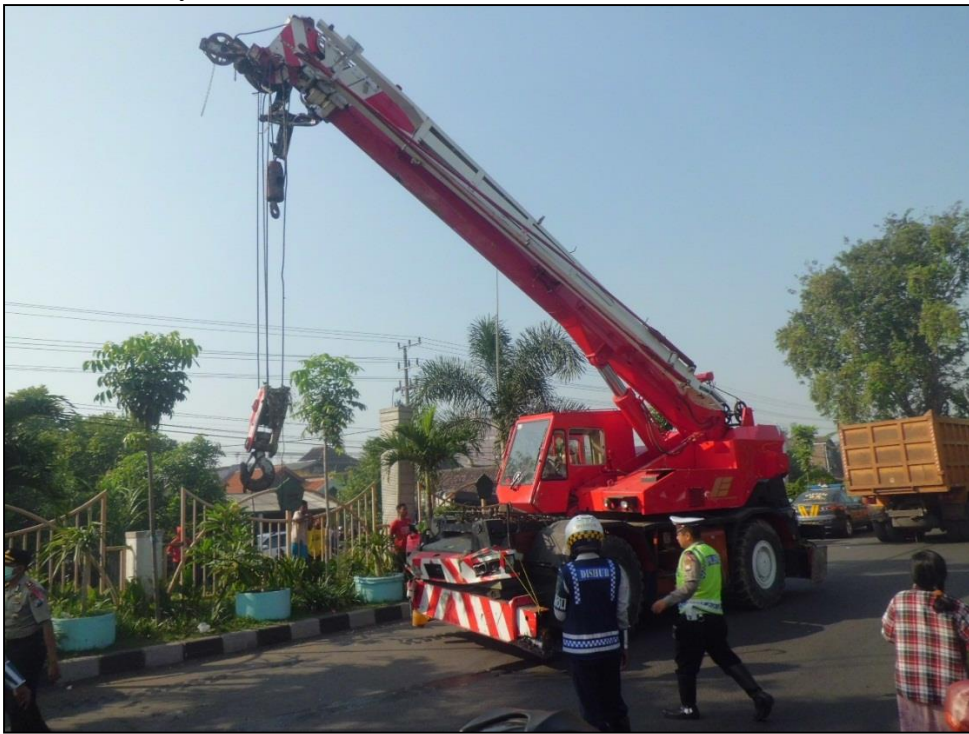
Gambar 2. Mobil crane yang terlibat pada kecelakaan.
