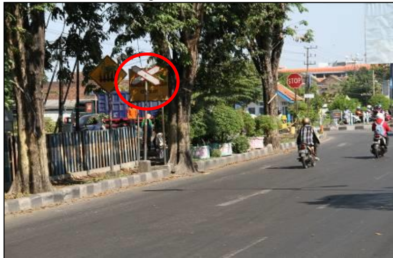
Gambar 24. Rambu peringatan Hati-Hati Mendekati Perlintasan Sebidang Kereta Api (Tabel II no. 9) yang tertutup rambu Papan Andreas (Tabel III no. 1e).
