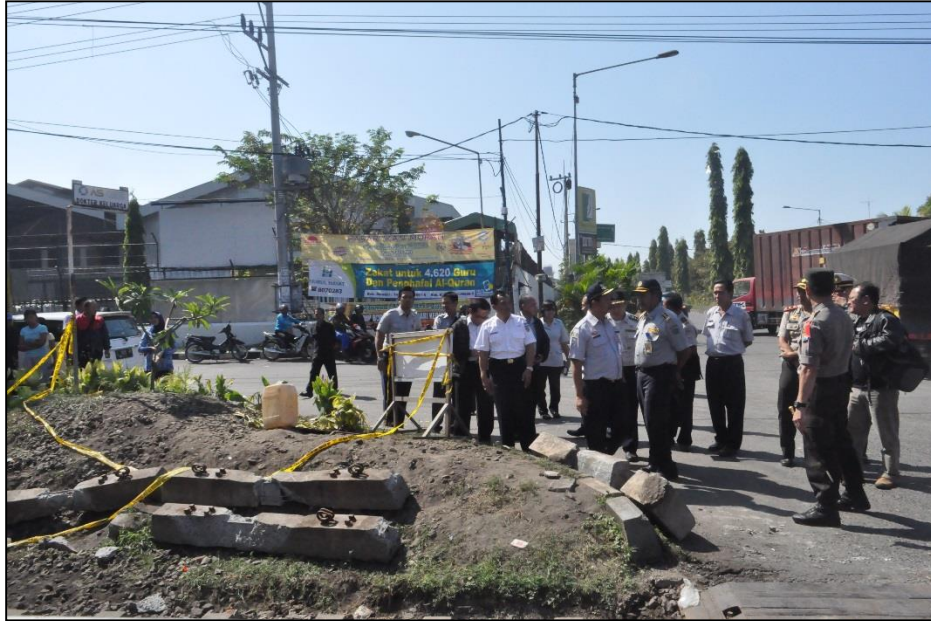
Gambar 22. Bantalan kereta yang rusak.
