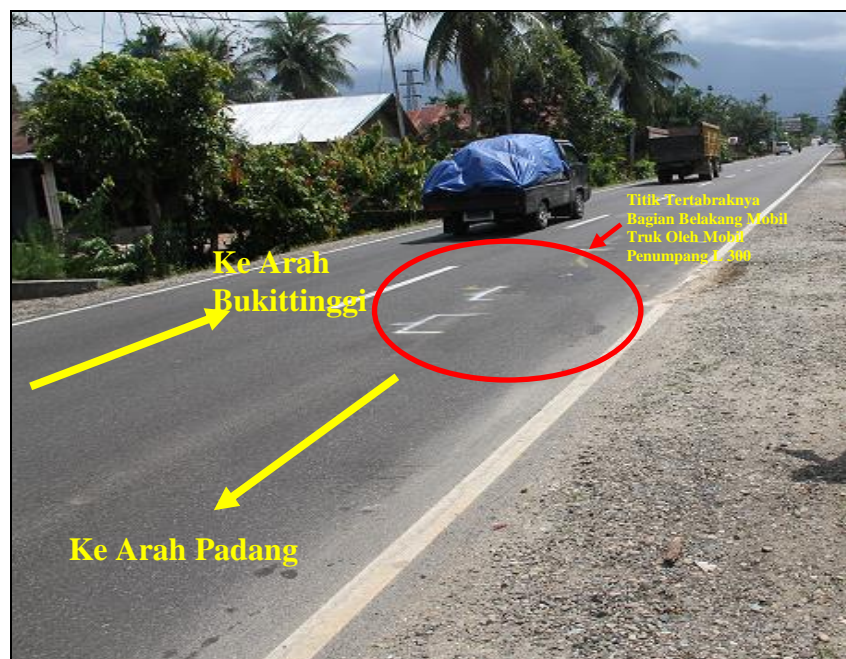
Gambar 6. Kondisi Jalan dilihat dari arah Padang ke Bukittinggi
