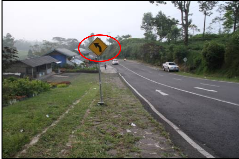
Gambar 18. Rambu tikungan ke kiri ruas jalan Cicenang, Lembang arah menuju Subang.
