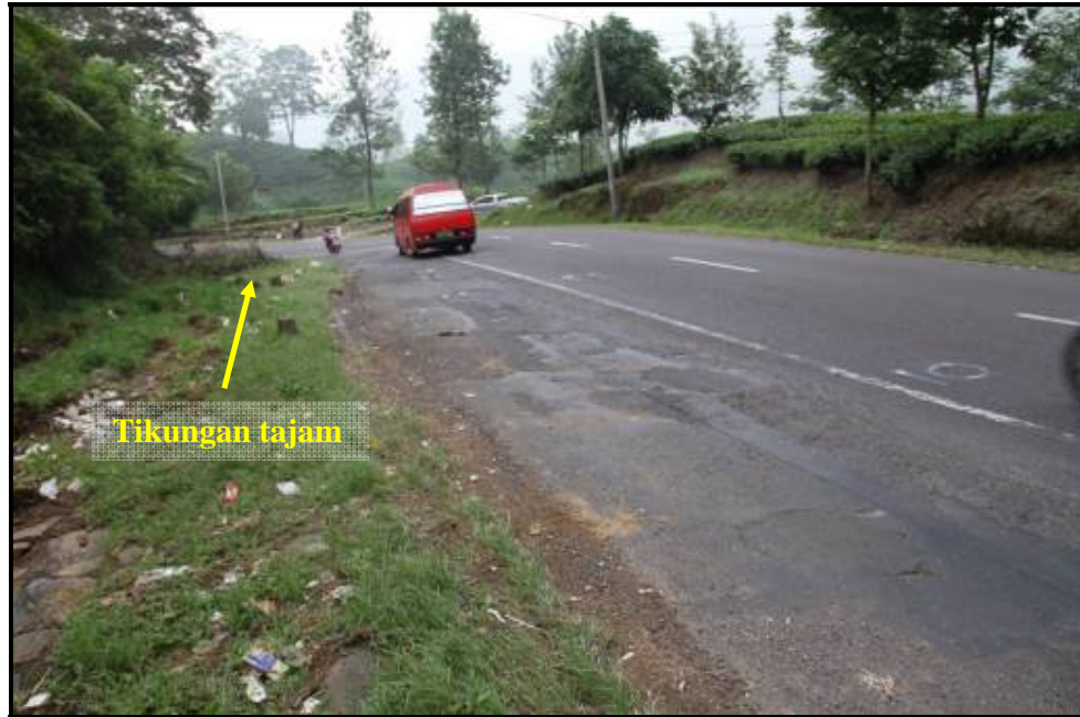
Gambar 25. Kondisi jalan sebelum lokasi kejadian dimana jalan menurun dan tikungan ke kiri patah
