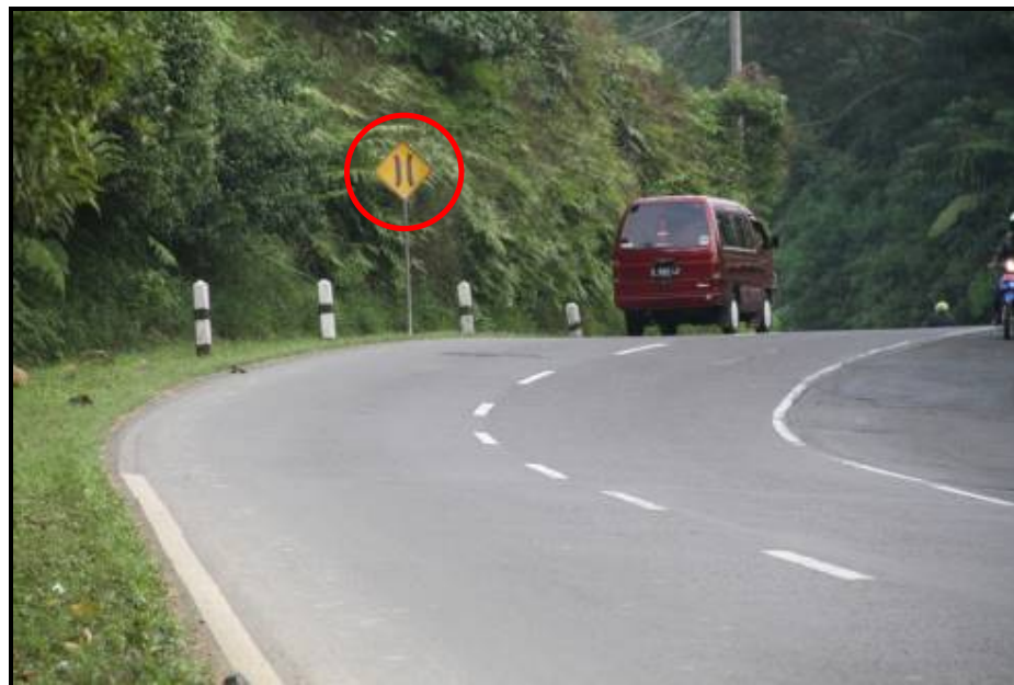
Gambar 21. Rambu jembatan sempit ruas jalan Cicenang, Subang arah menuju Lembang.
