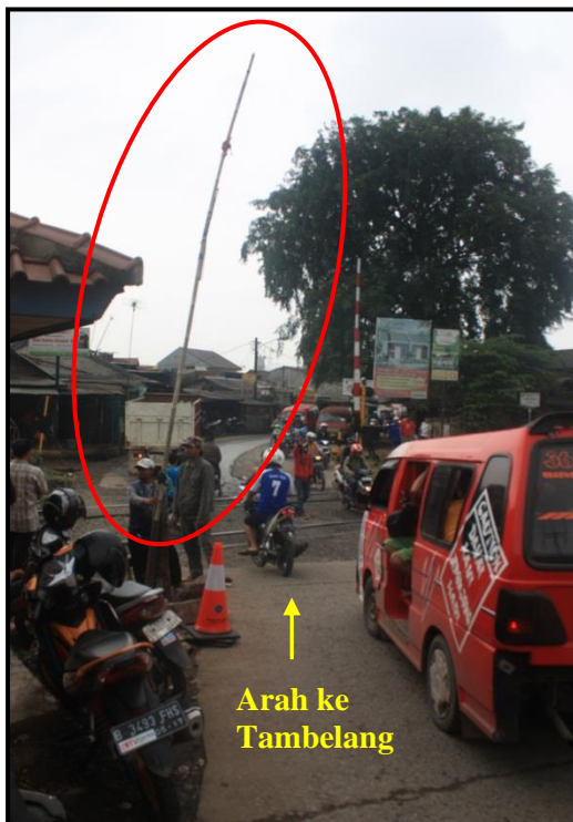
Gambar 30. Palang pintu perlintasan dari arah Cibitung menuju Tambelang terbuat dari bambu.
