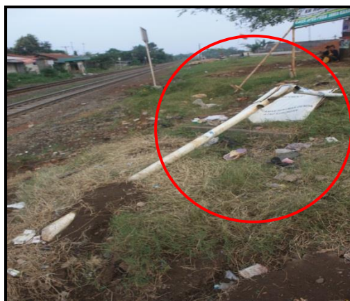
Gambar 10. Papan himbauan yang roboh karena tertabrak bodi mobil bus.
