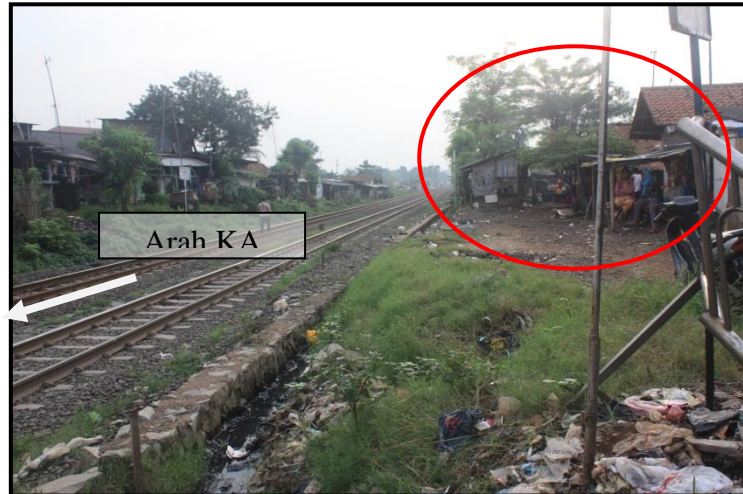
Gambar 26. Rumah penduduk dan kerimbunan pohon yang menghalangi pandangan pengguna jalan terhadap datangnya kereta api dari arah St. Tambun.
