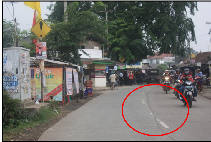
Gambar 25. Marka tengah yang terlihat buram.
