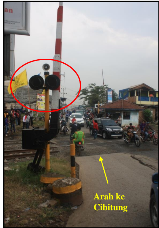
Gambar 29. Loudspeaker dan lampu merah berkedip tidak berfungsi.
