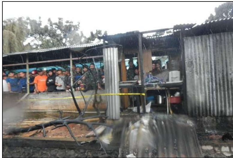
Gambar 12. Kondisi bangunan yang rusak akibat kecelakaan
