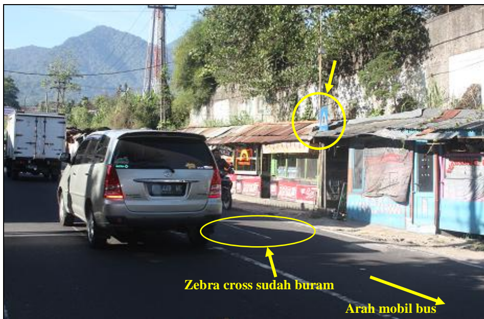
Gambar 11. Rambu petunjuk lokasi fasilitas penyeberangan pejalan kaki 200 m sebelum lokasi kecelakaan dan zebra cross warna catnya sudah buram.
