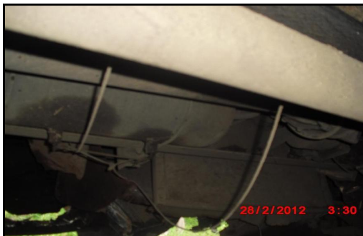
Gambar 20. Masih terdapat sisa angin pada tangki udara (tidak terdapat kebocoran)
