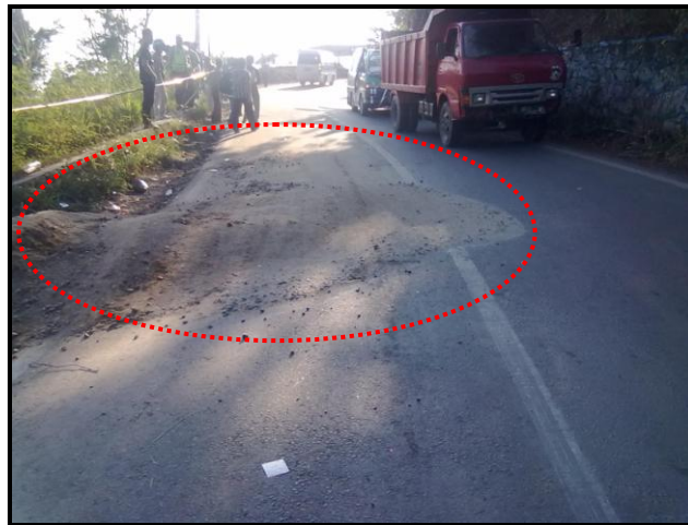
Gambar 11. Gundukan material yang menutupi sebagian badan jalan
