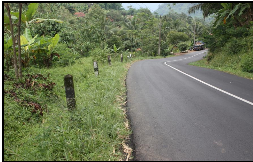
Gambar 7. Kondisi Ruas Jalan Wado - Sumedang
