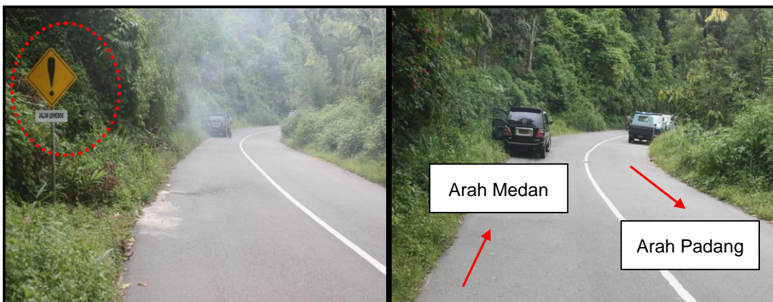
Gambar 13. Rambu yang baru dipasang yang berjarak sekitar 150 m dari lokasi kejadian
