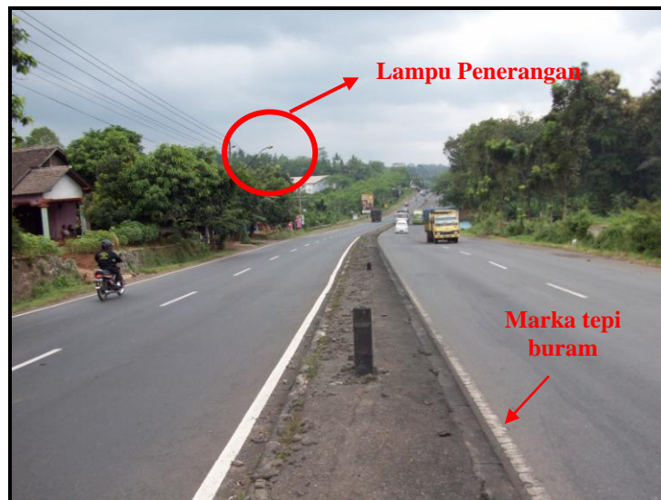
Gambar 6. Kondisi Jalan Cekelan, Batang-Jawa Tengah beserta lampu penerangan jalan umum
