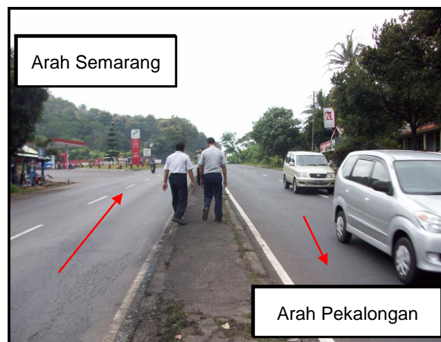
Gambar 9 Kondisi Jalan Raya Cekelan
