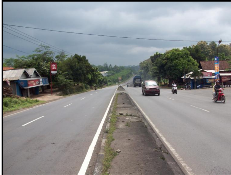
Gambar 5. Kondisi Jalan Cekelan, Batang-Jawa Tengah yang tidak ada rambu-rambu peringatan.
