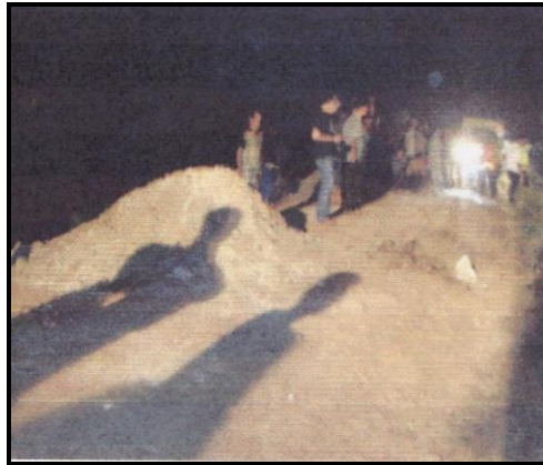
Gambar 6. Gundukan agregat yang memakan separuh jalan
