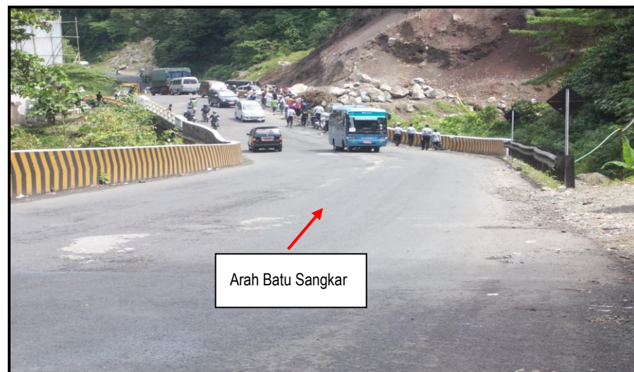
Gambar 11. Kondisi jalan di lokasi kejadian
