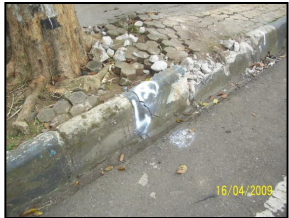
Gambar 6. Titik benturan roda depan dengan trotoar
