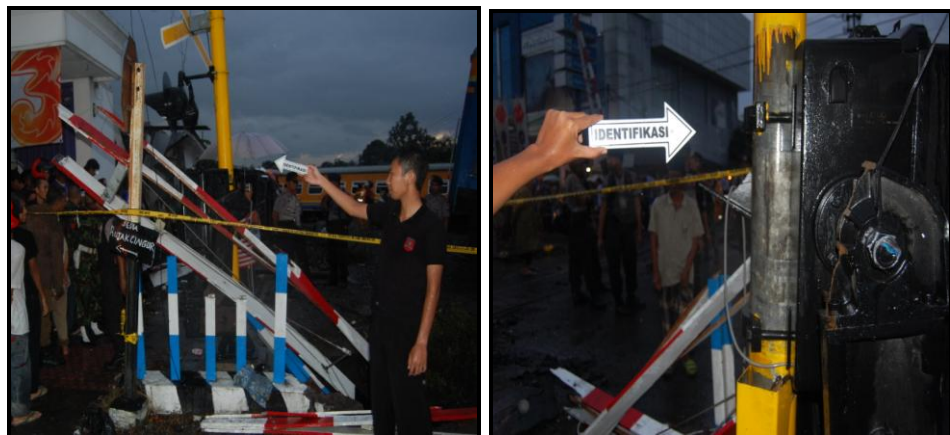
Gambar 16. Pintu perlintasan yang rusak akibat ditabrak mobil bus AG 7493 UR
