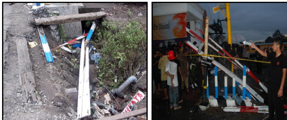
Gambar 4. Palang pintu perlintasan yang rusak akibat ditabrak mobil bus Harapan Jaya
