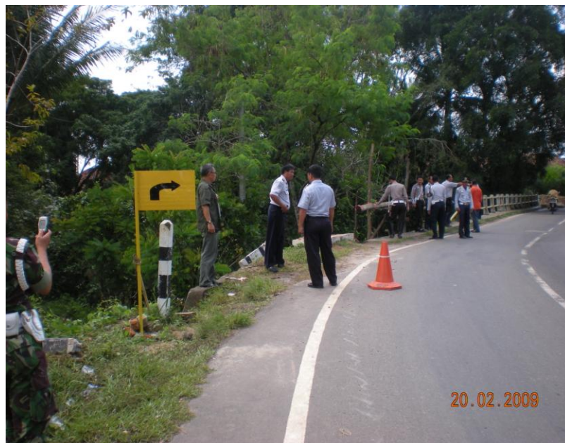
Gambar 6. Rambu peringatan tikungan yang tidak standar
