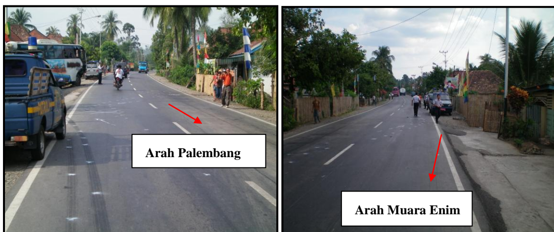
Gambar 5. Kondisi ruas jalan lintas Sumatera Lahat Muara Enim
