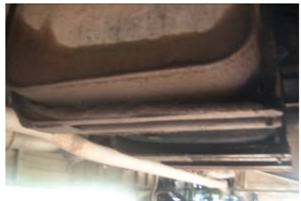
Gambar 28 kondisi tangki bensin yang tidak terbakar
