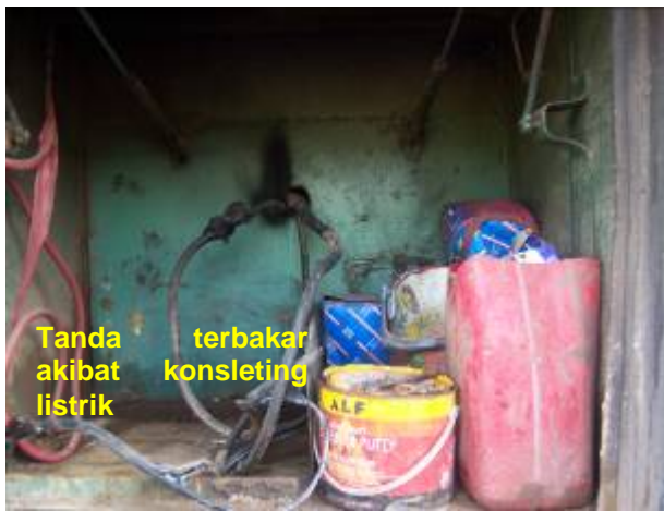
Gambar 19 kondisi tempat penyimpanan aki battere
