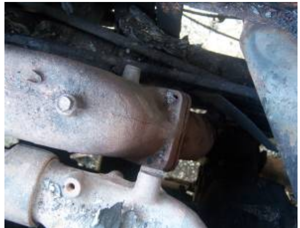
Gambar 24 kondisi selang yang tidak ada bautnya
