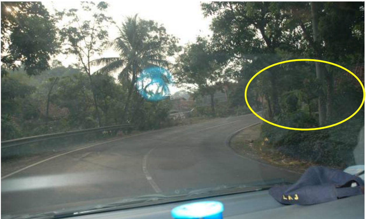
Gambar Prasarana 2 : Jarak pandang untuk melihat kendaraan yang datang dari arah berlawanan terhalang oleh pohon yang ada di sebelah kanan
