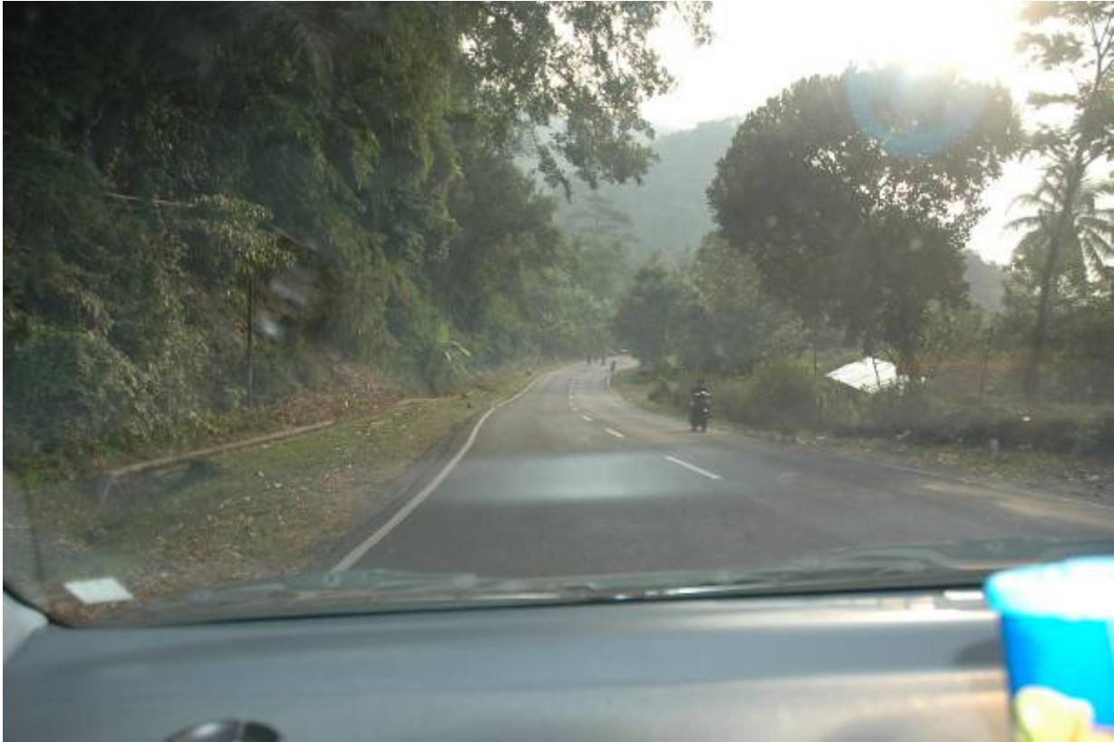
Gambar Prasarana 3 : Kondisi jalan sejak pertama bus menabrak angkot sampai dengan lokasi kejadian kedua tidak terdapat tanda rambu – rambu lalu lintas.
