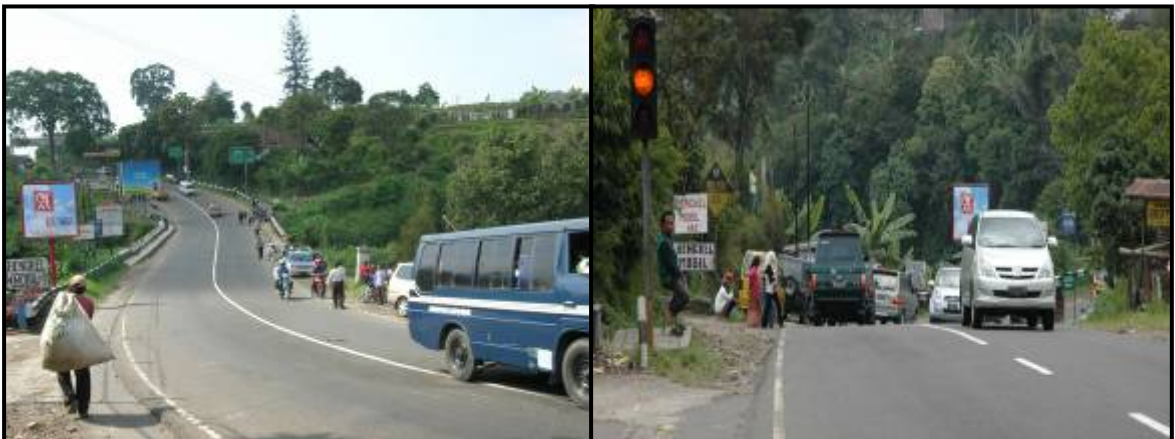
Gambar 2.10 Prasarana jalan disekitar lokasi kejadian diteliti setidaknya 2-3 Km sebelum tempat terjadinya kecelakaan, kondisi jalan beraspal baik, dengan descriptive geometry menurun (dengan kemiringan sekitar 5 %), dan panjang lintasan menurun lebih dari satu kilometer dan menikung ke kanan, kemudian setelah jembatan yang menjadi tempat kejadian kecelakaan ada tanjakan. Jalan telah dilengkapi dengan marka, baik marka tepi kiri dan kanan maupun marka garis tengah utuh dan tidak putus-putus. Kondisi marka walaupun banyak yang sudah buram, namun masih cukup jelas.
