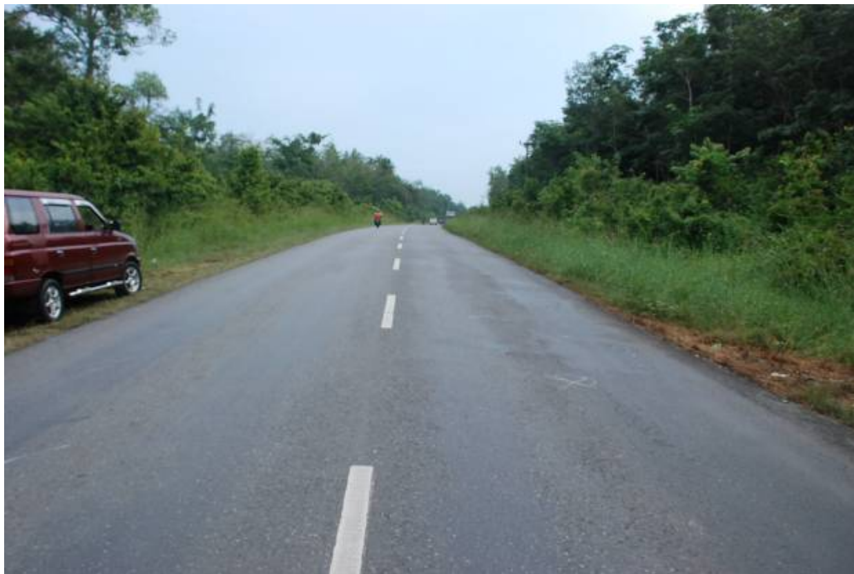
Gambar 2 Lokasi Kejadian Kecelakaan
