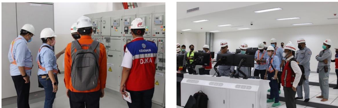
Gambar 110. pemantauan kesiapan fasilitas depo dan operation control center LRT Jabodebek
